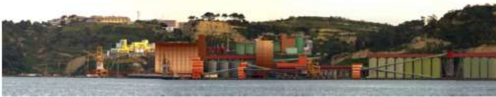
Figura 26 - Instalação Sovena Oilsseds Portugal após a conclusão dos trabalhos de Requalificação (dia)
