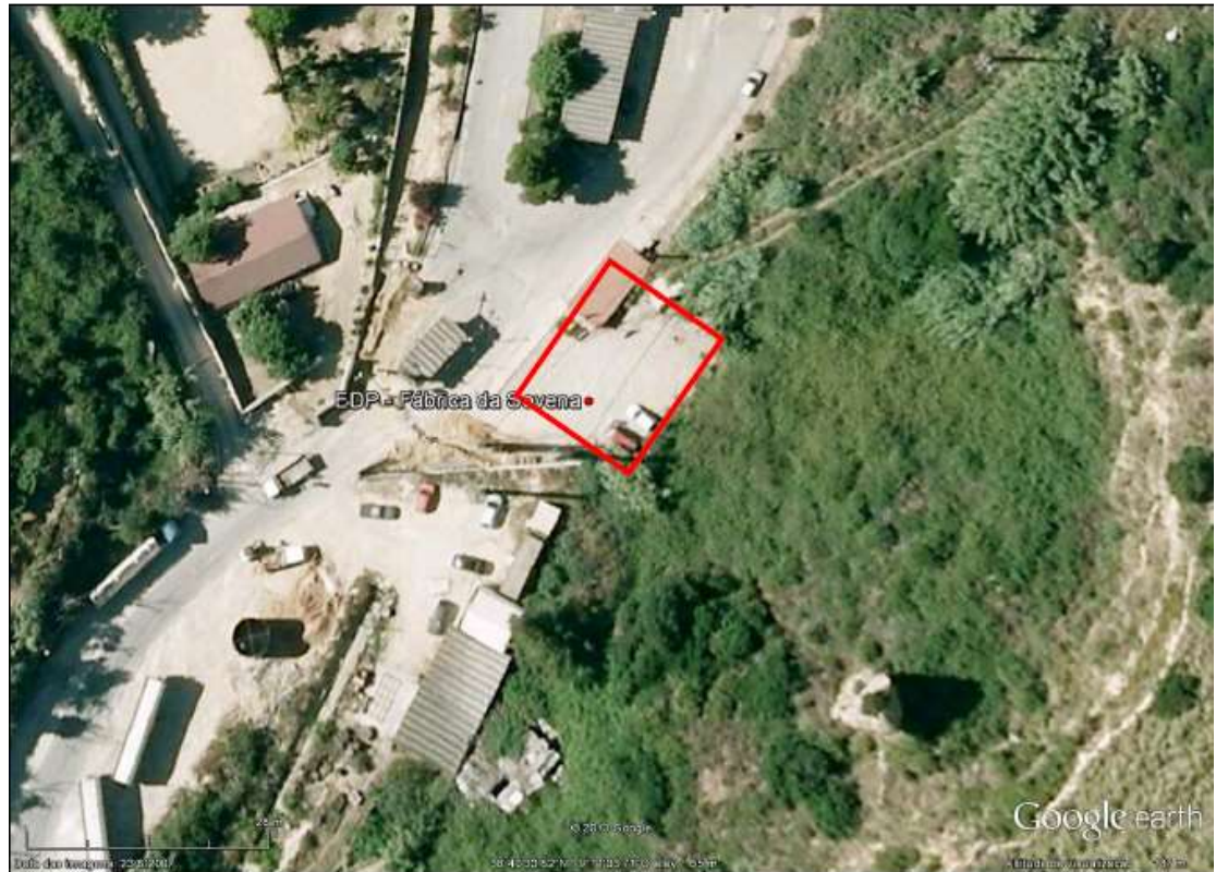
Figura 18 - Vista aérea do local de implantação da futura subestação
